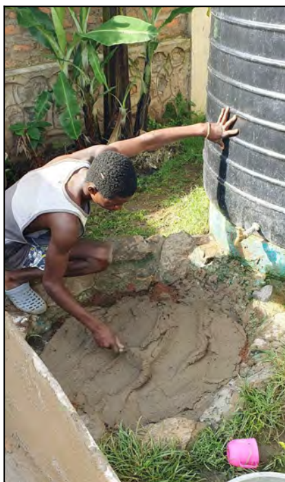
Betonujeme....oprava miesta na pranie.
